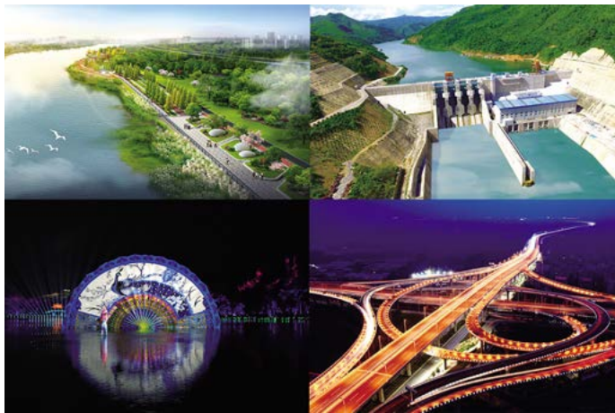
中国电建承建项目
